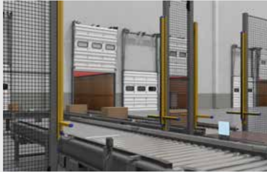
Contrôle de passage sélectif Matériel / Personne
